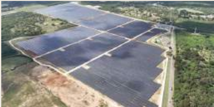
130 MW Parque Solar Coastal San Pedro de Macorís, Rep. Dom.
