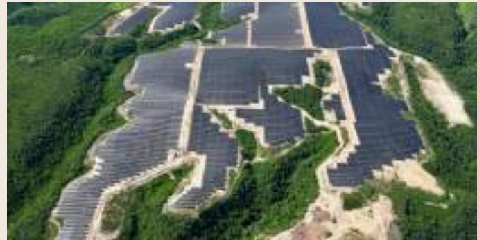
80 MW Parque Solar Sajoma San José de Las Matas, Santiago, Rep. Dom.
