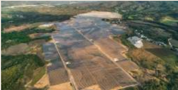
120 MW Parque Solar Girasol Yaguatape, San Cristóbal, Rep. Dom.
